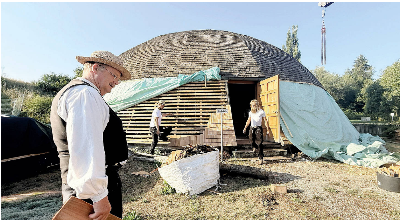
Zimmerermeister Hubert Nowack gewährt Einblicke in die derzeit laufenden Sanierungsarbeiten: Unter anderem wird der Rundbehälter mit 22.000 neuen Schindeln aus Zedernholz neu eingedeckt. Fotos: Stadt Rottweil / Hermann
