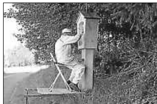
Restaurierung Kreuzweg Minderstetten
